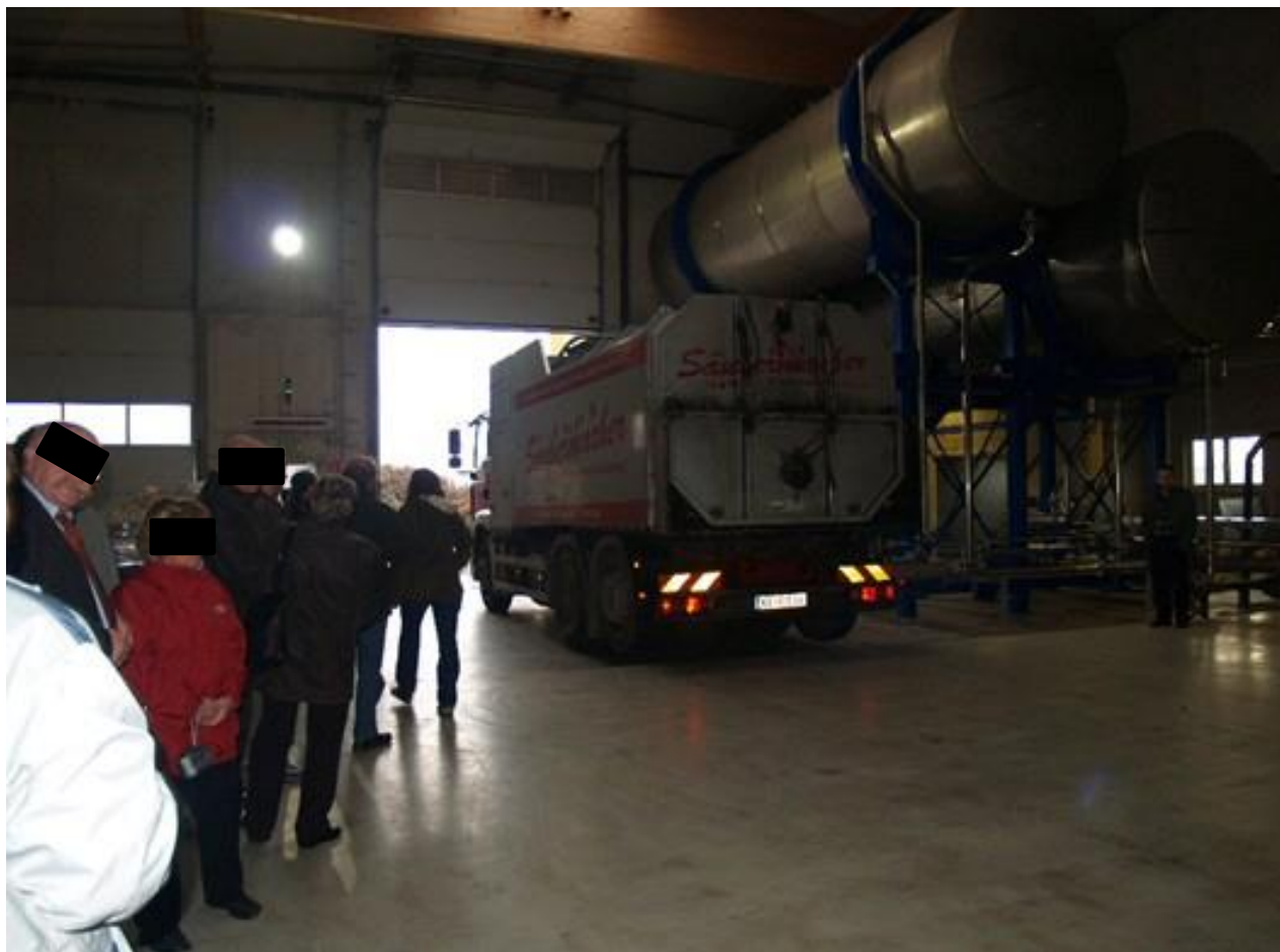
Obrázek 1: Příklad příjmové stanice z referenční stavby v rakouském Zwenderdorfu
