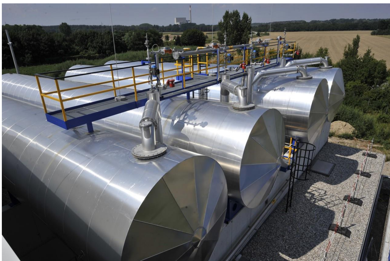
Obrázek 3: Příklad horizontálních fermentorů z referenční stavby v rakouském Zwenderdorfu
